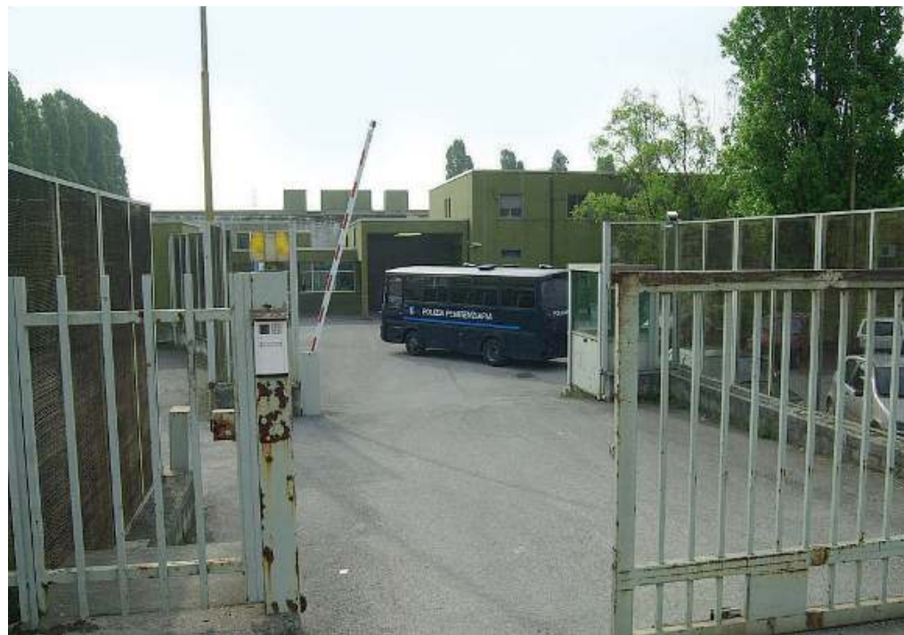
Ingresso. L'attuale carcere di Verziano verrà ampliato, arrivando a una capienza di 400 detenuti
